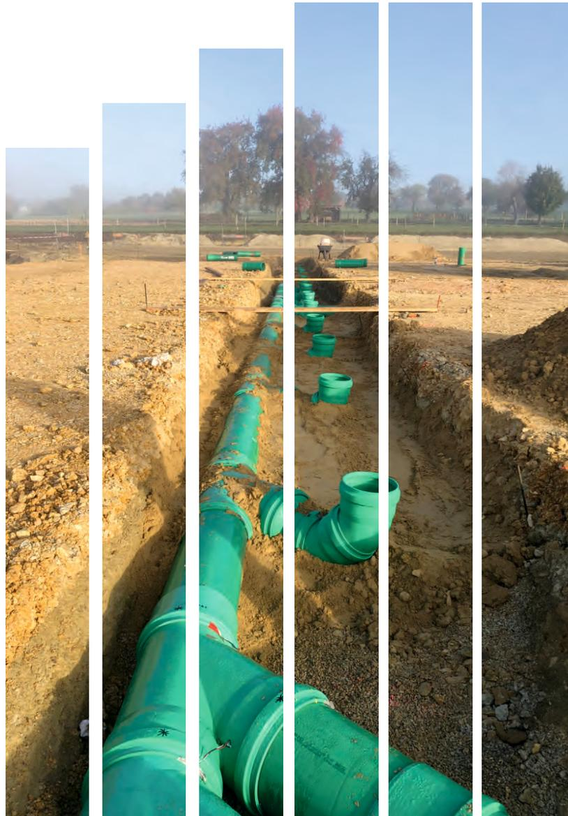
Das IP-*plus* Schweißsystem bietet die Möglichkeit auf der Basis vom KG 2000 Kanalrohrsystem aus Polypropylen ein hochmodernes komplett verschweißtes Rohrsystem herzustellen. Das IP-*plus* Schweißsystem ist so konzipiert, dass das KG 2000 Kanalrohrsystem direkt vom Lager der Handelshäuser verwendet werden kann. Der Schweißring ersetzt den Gummidichtring direkt. Die Anbindung von Schachtsystemen und Straßeneinläufen aus Polypropylen ist ebenfalls ohne besondere Umstände möglich.
