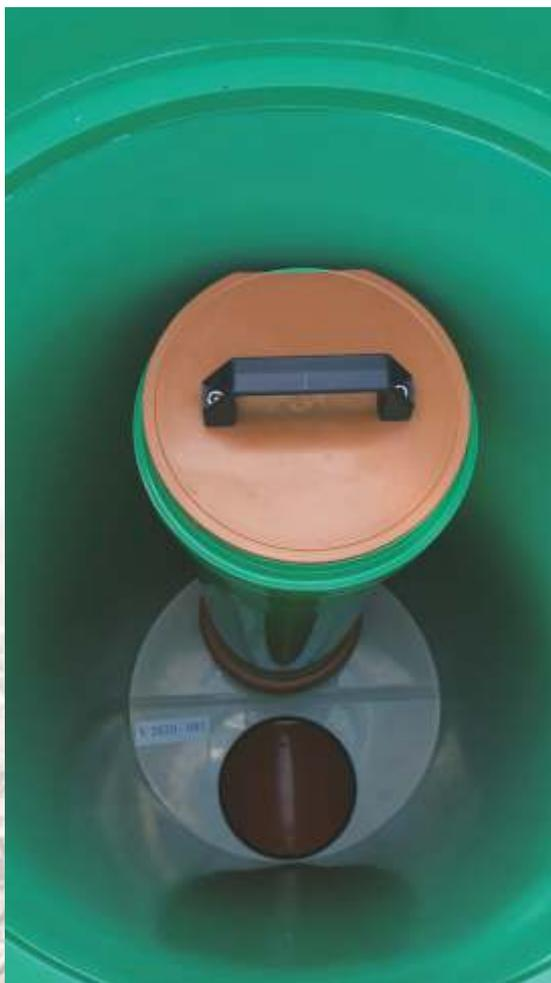
Tiefer Trennschacht DN 400 mit Stopfenverlängerung angepasst auf die effektive Einbautiefe.
