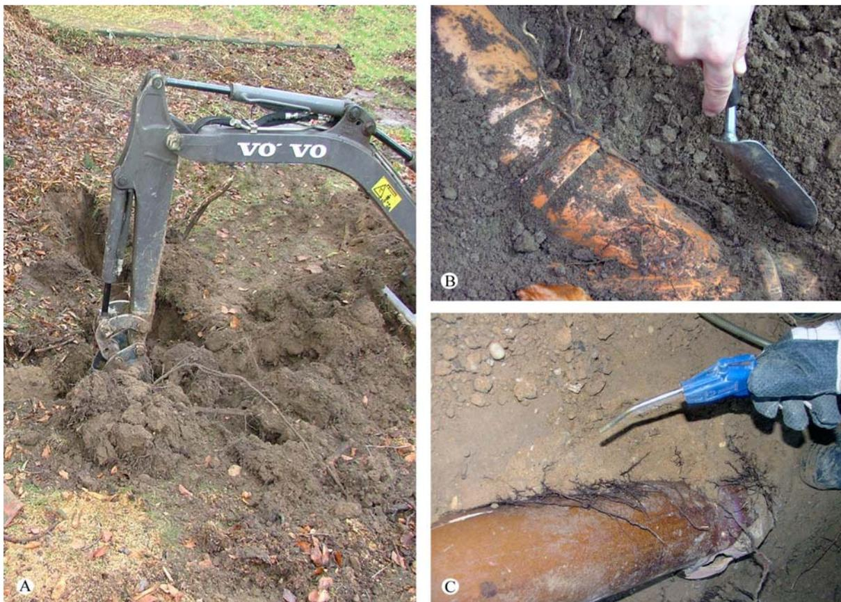
**Abb. 10:** Aufgrabungstechniken. **A** Aufgraben der Oberfläche und Aushub mit dem Bagger; **B** Freilegen des Leitungsbereichs von Hand; **C** Säubern der Wurzeln und der Leitungsoberfläche mit Druckluft.
