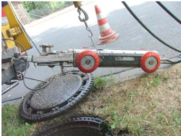
Abb. 58: Einbringen des Fräsroboters zur Wurzelentfernung in einen Schacht des Hauptkanals in der Schermebecker Straße in Raesfeld.
