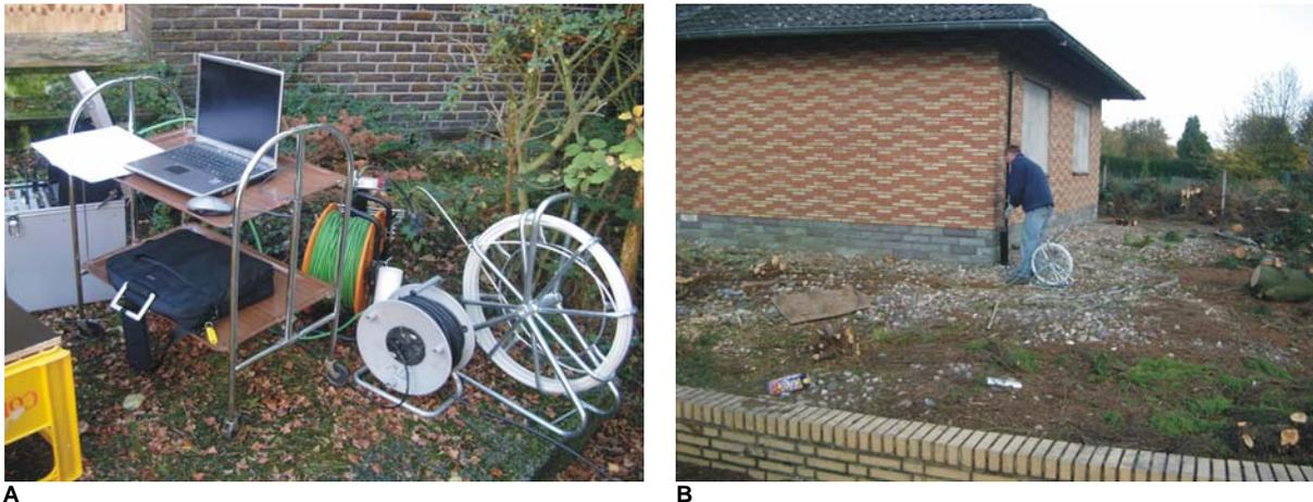
**Abb. 8:** Inspektion der Hausanschluss- und Grundstücksentwässerungsleitungen **A** Die Inspektion der Leitung wurde vom Keller des Hauses aus vorgenommen und die Daten wurden über ein Kabel, welches ein Kellerfenster passiert, nach außen geleitet. **B** Inspektion einer Regenfallleitung, um eine weitere Zugangsmöglichkeit der Leitung zu prüfen.
