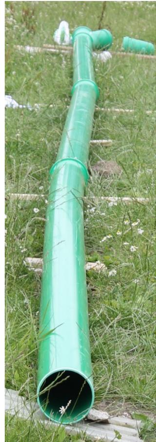
Beachten Sie, dass beim Schweißvorgang die Bauteile plastisch werden. Ohne ausreichende Absicherung (Unterstützung) werden sich die Bauteile während des Verschweißens verformen.
