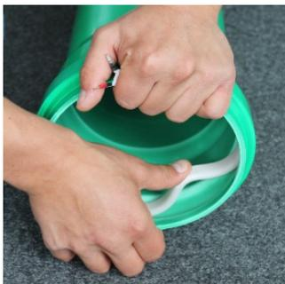
4. Bitte drücken Sie nun den Schweißring mit dem Daumen in die Sicke und beachten Sie die korrekte Lage der Anschlusskabel zu den Nuten im Muffenhals.
