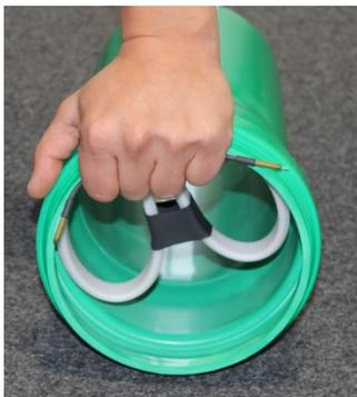
1. Der Ring wird nun aus der Tüte entnommen und wie im Bild dargestellt, im oberen Bereich der Sicke gehalten.
