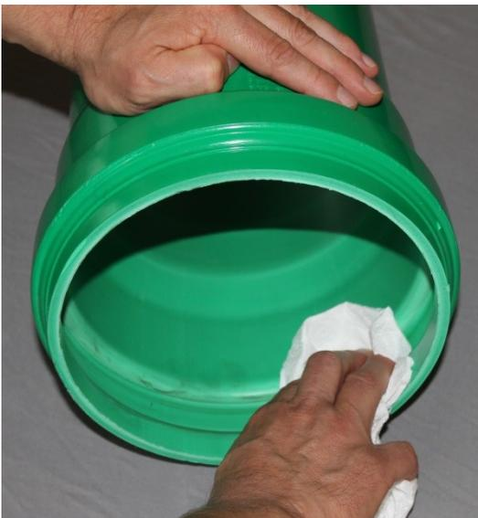
**Für die Herstellung einwandfreier Schweißverbindungen ist die Sauberkeit und Fettfreiheit der zu verschweißenden Oberflächen von entscheidender Bedeutung. Das Entfernen einer „Oxidschicht“ durch Schälen im Schweißbereich ist nicht notwendig!**
