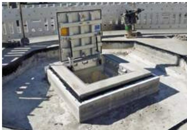
Weitere Alternativen wie z.B. Edelstahlabdeckungen oder Flansche lassen sich ebenfalls direkt auf die Schachtröhre aufsetzen.
