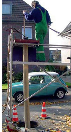
Sanierung von Wurzelschäden: Ein Schlauchliner wird vom Hauptkanal aus eingezogen. Der Liner selbst ist wurzeldicht.
