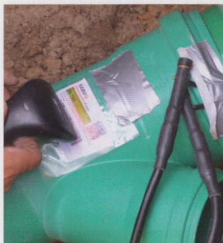
Verbindung des Systems: Mittels eines Bar-Codes werden die erforderlichen Schweißparameter in das Gerät eingelesen. | Foto: SWO Netz GmbH
