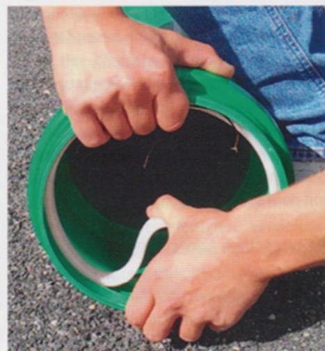
Einlegen des vorverformten IP-plus Schweißbrings | Foto: SWO Netz GmbH
