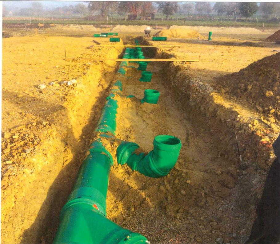
Als erstes und einziges Kunststoffrohrsystem hat das KG2000 die bauaufsichtliche Systemzulassung beim DIBt für den Einsatz als JGS-Leitung erhalten. Nur dieses Vollwandrohrsystem darf in Kombination mit dem Schweißsystem IP-plus in JGS-Anlagen für unterirdische, drucklose Rohrleitungen eingesetzt werden.
