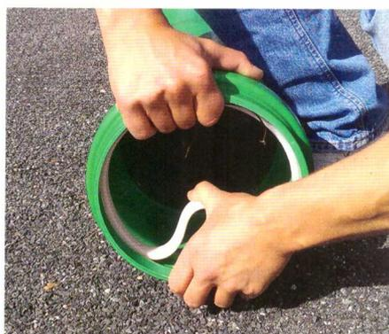
Zur Verschweißung wird der Gummidichtring aus der Rohrsicke des Rohrsystems entnommen und durch den IP-plus Schweißring ersetzt. Eine Änderung des vorhandenen Rohrsystems ist nicht notwendig. | Fotos: Sabug
